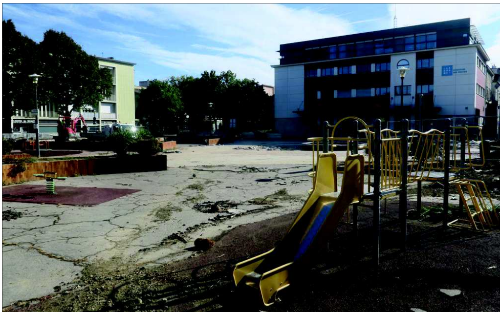
Le chantier a débuté depuis quelques jours place Manouchian, et s'est invité, comme souvent, au conseil municipal, délocalisé hier soir au conseil départemental pour des raisons de travaux dans la salle du conseil de l'hôtel de ville.
